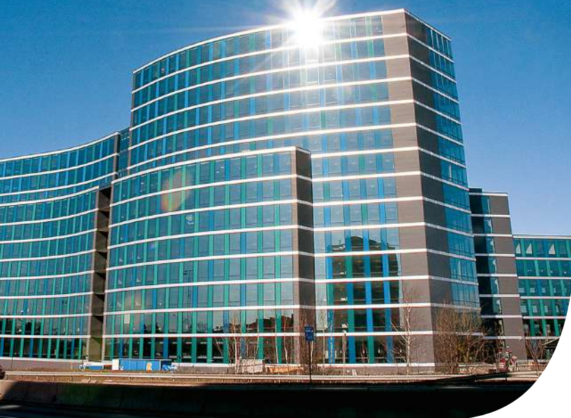
Foto: Trond Løvelsen / Byggeindustrien
