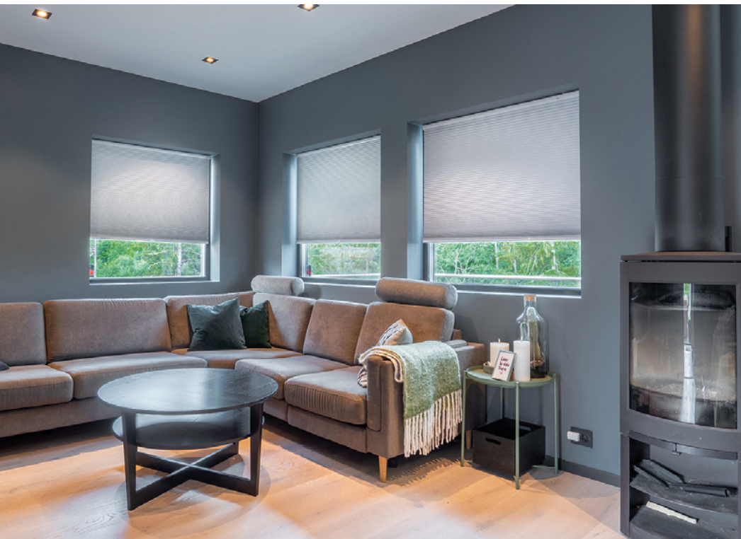
Innvendig avskjerming som dekker deler av glasset kan medføre termisk brudd som følge av temperaturforskjell i overflaten. Foto: Jonas Ingstad
