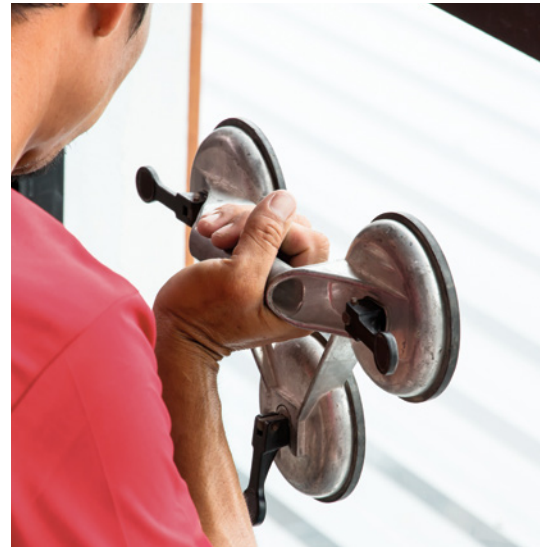
Eksempel på delaminering. Kondens/dugg kan forekomme på innsiden, utsiden eller mellom glassene i en isolerrute. Løfteutstyr med sugekopper kan gi avsetninger på glasset i form av sirkelformede merker. Foto: GF
