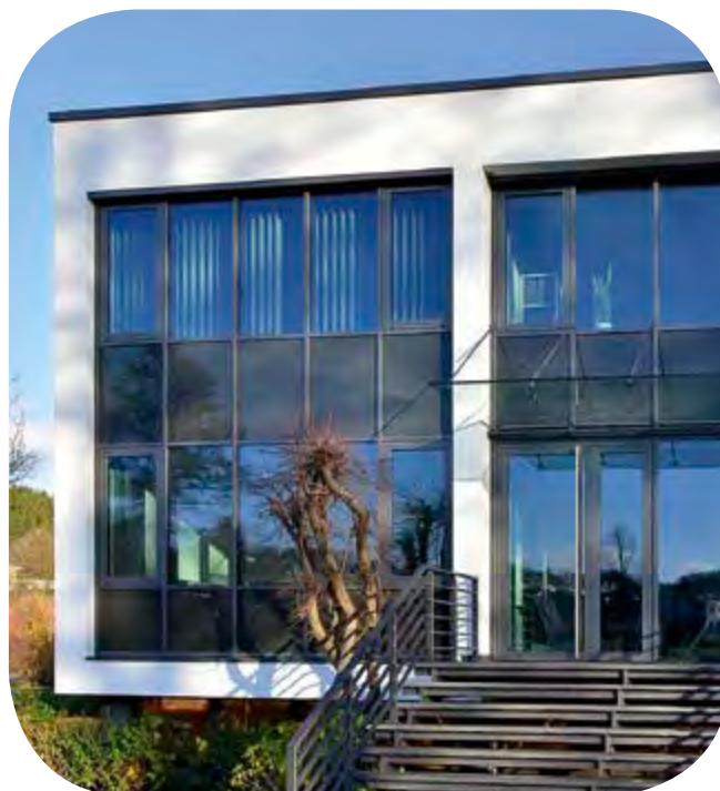
Kontorbygg, Sundern, Tyskland. Pilkington Suncool™ Q 60
